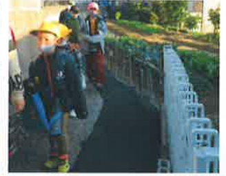
修復した路肩安心して通学が出来ます
